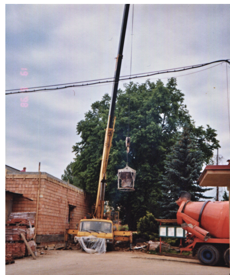
Leuze, přístavba klimatizace, 1998
