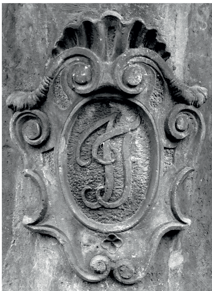
Detail kartuše s iniciálami Ignáce Falge
