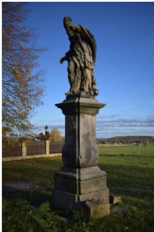
Současný stav díla – celkový pohled
